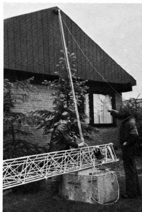
3. 1 stk. spil monteres på mast. Teleskopmast er klar til montering på vippestativ. Det vil være en fordel at føre masten på plads med spil, fastgjort som vist, eller ophængt i montagetreben. Dorn placeres i vippebeslag. Vigtigt: Vent med at montere mastetop og rotor til masten er på plads.
